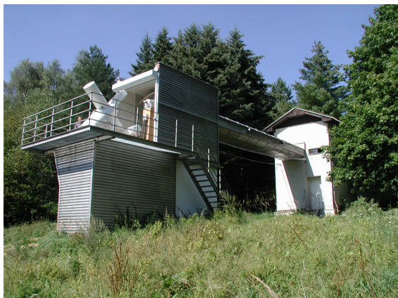
Obr.3: Horizontální sluneční dalekohled se spektrogra-fem, označovaný HSF A1, v němž byl v letech 1990 - 2001 provozován sluneční magnetograf II. V přední části obrazu vidíme coelostat s průměrem zrcadel 600 mm.
